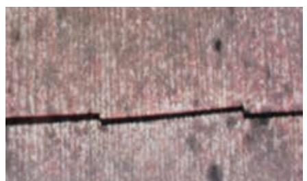
全体に塗膜の剥がれが見られ、下地表層は脆く、吸込みが大きい状態。
