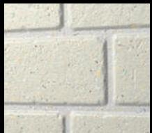
塗装する2色の明るさが同じであり、かつ色みが近い色で塗り重ねてしまうと模様がなじみすぎてわかりにくくなります。ダブルトーンダイヤモンドの特徴であるダイヤモンド塗装も引き立ちません。
